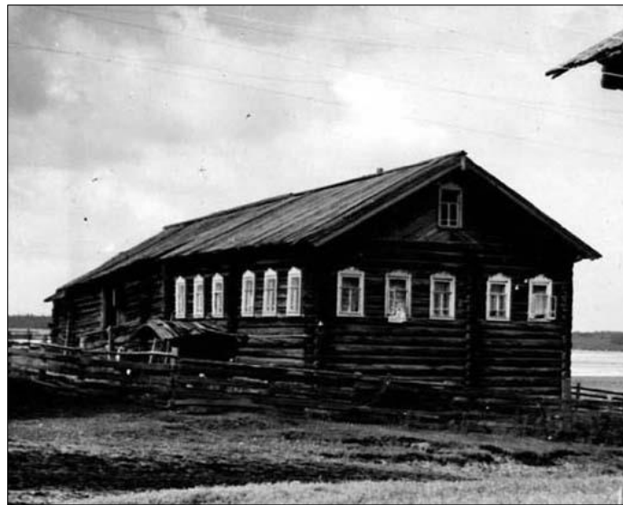
Дом жилой в д. Кальи. Дом Валовой Г.Н, построен во второй половине 19 века. Дом сгорел во время пожара 2006 года.
