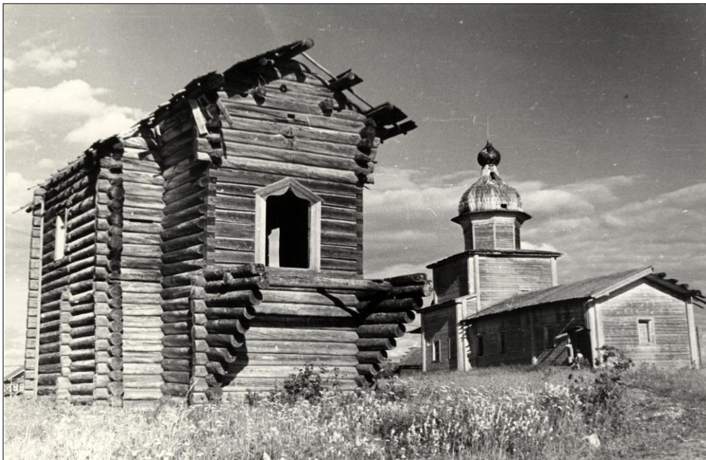
Рис. 6б. Корбала. Ильинская церковь. Разрушение. Фотоснимок 1940-х гг.
