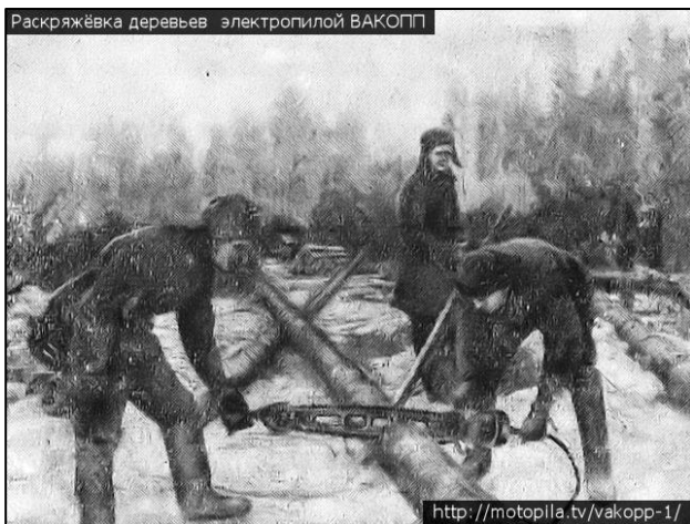
Раскряжевка леса электропилой ВАКОПП-1
