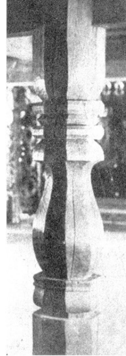
Рис. 10. Шастки. Колонна на втором этаже церкви.
